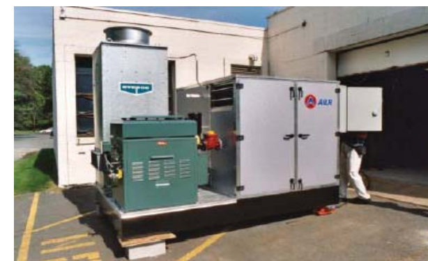
Tecnología de enfriamiento evaporativo con desecante sólido.
